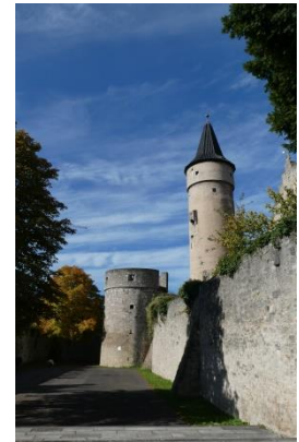
Dicker Turm und Nikolausturm
